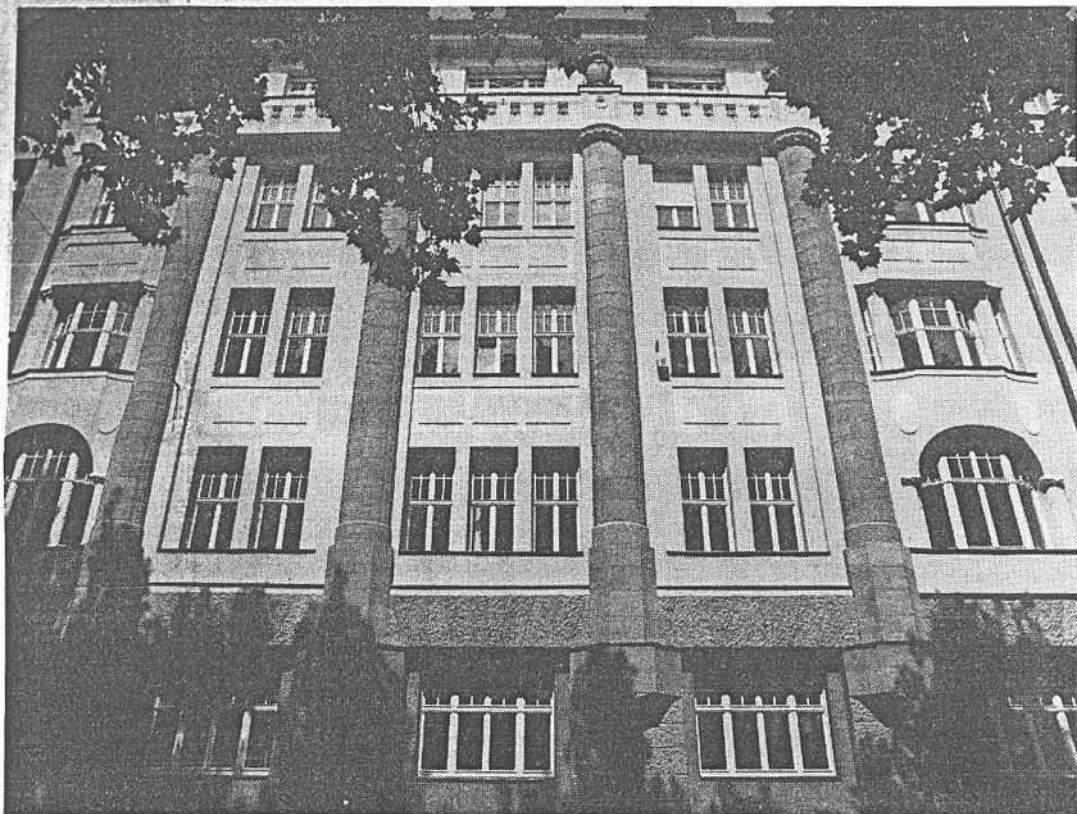
Vorbildlich restauriert: das Gebäude am Prinzregentenufer 9.
